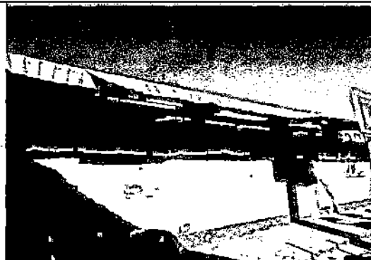
Foto 4: lámina de baja calidad deteriorada por condiciones climáticas, lo que provoca mal drenaje de lluvias y riesgo para los niños
